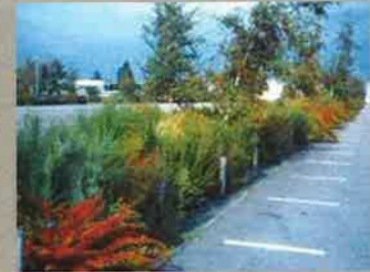
Parking avec noue centrale paysagère (AESN)
