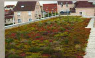
Toiture terrasse végétalisée (AESN)
