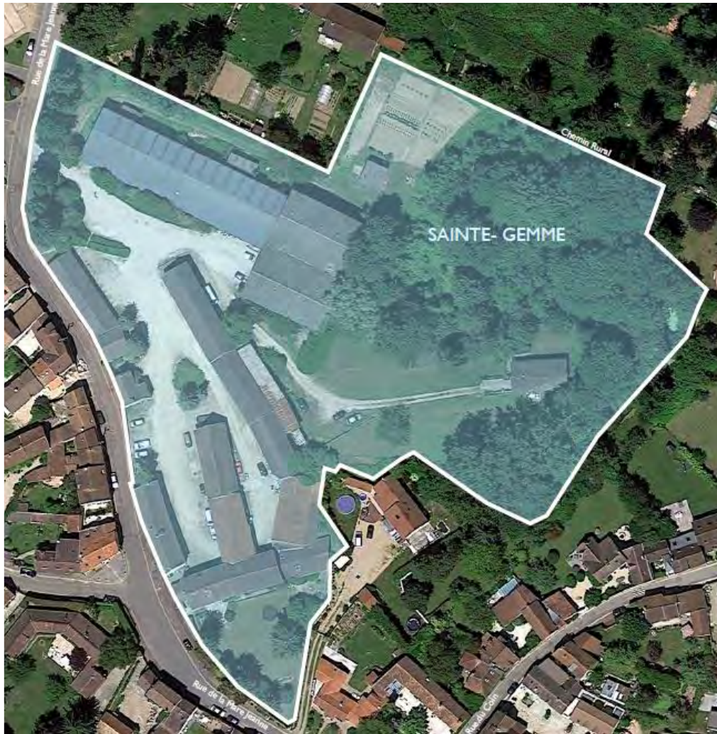
Photographie aérienne du secteur de « Sainte-Gemme » et périmètre du projet
