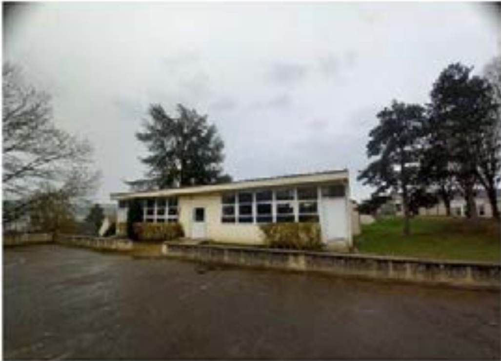
Vue 1 : Le préfabriqué de l'accueil périscolaire
