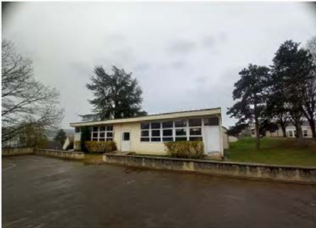
Vue 1 : Le préfabriqué de l'accueil périscolaire
